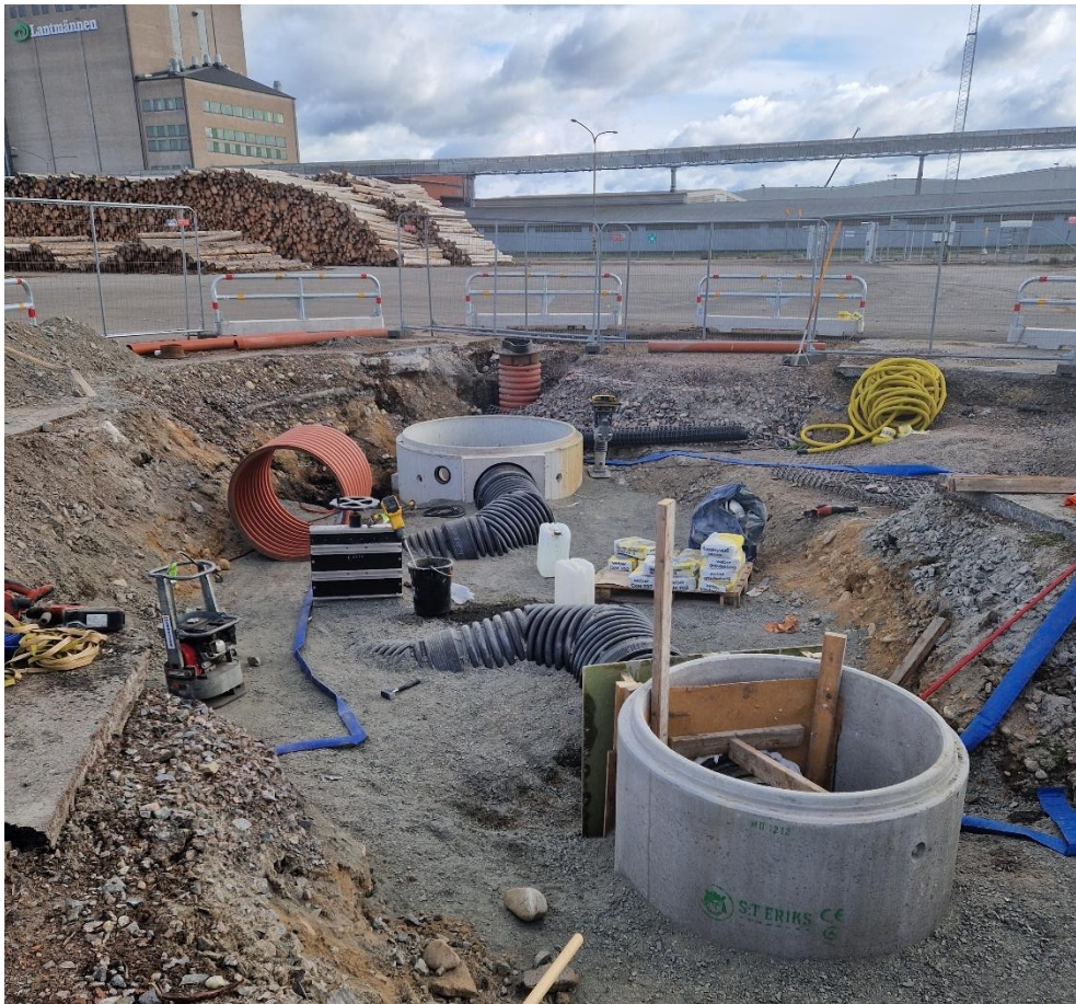
Figur 3: Installation av pumpstation på Öhmansterminalen.
